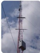
Panneaux photovoltaïques (les 2 au milieu) et boîtiers d'enregistrement (de part et d'autre)
